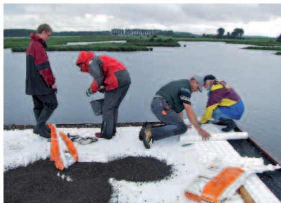
Fleißige Helfer bereiten das Dach für die Bepflanzung vor. [P. Apke]
