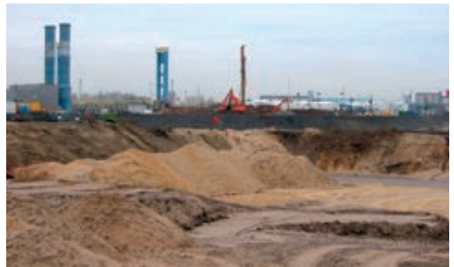
Baugrube für das umstrittene Kraftwerk (im Hintergrund die Katwyckbrücke)
