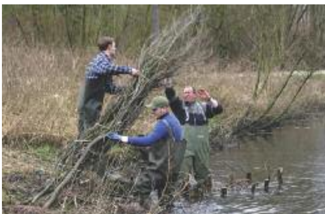
Arbeitseinsatz an der Wandse [M. Schmolinske]
