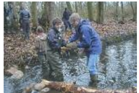
7. März, Rahlau in Wandsbek, östlich Ölmühlenweg: Das zu breite Bachbett der Rahlau wurde mit Hilfe von 4-5 Meter langen Baumstämmen auf Mittelwasserniveau eingengt, um den träge fließenden Bach wieder zum Strömen zu bringen. Außerdem wurde der lokal auftretende Japanische Staudenknöterich bekämpft. [Susanne Wieters]
