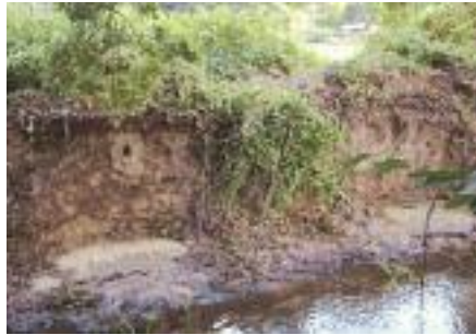
26. September, Schleemer Bach in Öjendorf, westlich Reinskamp: Helfer bauten zwei Steilwände für den Eisvogel als Brutmöglichkeit und Strömungslenker aus Kies und Totholz ein. [Eike Schilling]
