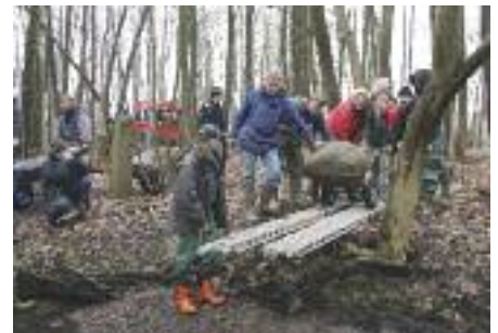
21. Februar, Berner Au in Tonndorf, südlich Kupferdamm: Noch im tiefsten Winter wurden in die Berner Au unterhalb des Kupferreiches Kiesbänke und Strömungslenker aus Kies und Geröll eingebaut. [Tobias Fedder]
