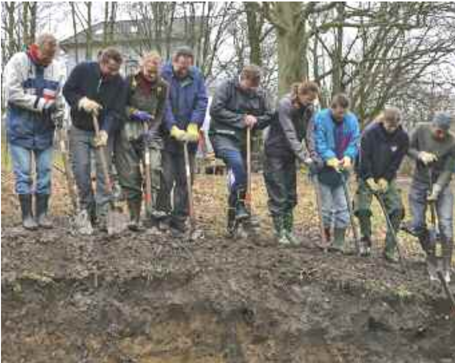
Teamwork für die Anlage naturnaher Uferstrukturen am Schleemer Bach
