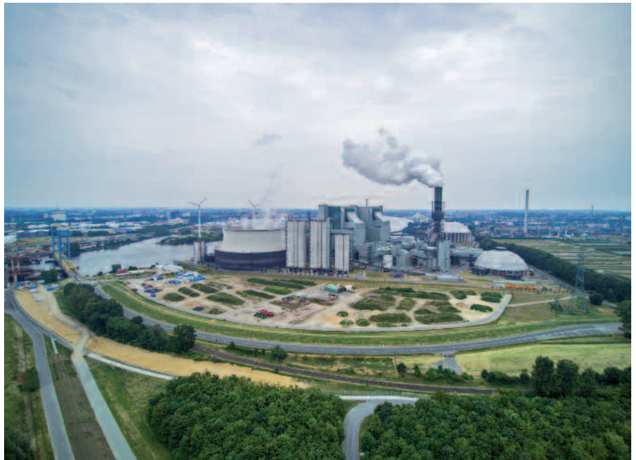
Am Standort des stillgelegten Kohlekraftwerks Moorburg könnte in den kommenden Jahren grüner Wasserstoff erzeugt werden [Adobe Stock]
