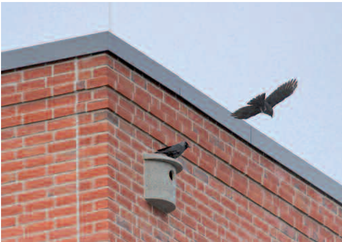
Nistkästen können auch direkt in die Fassade integriert werden. [M. Sommerfeld]
