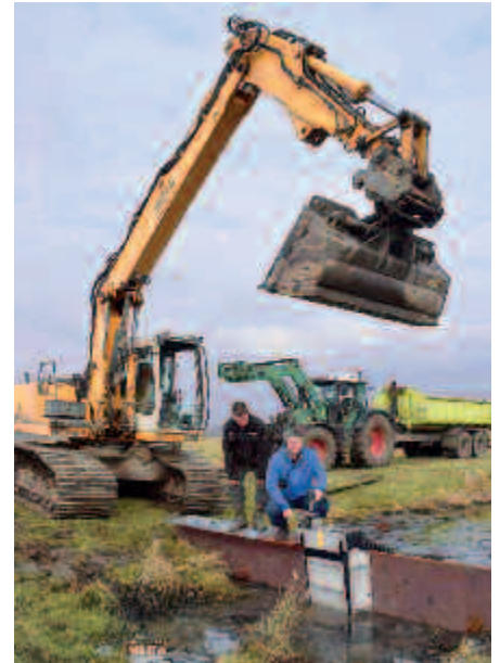
Gebietsbetreuer Christian Gerbich begleitete den Einbau der neuen Wehre [Diekmann/Bergedorfer Zeitung]
