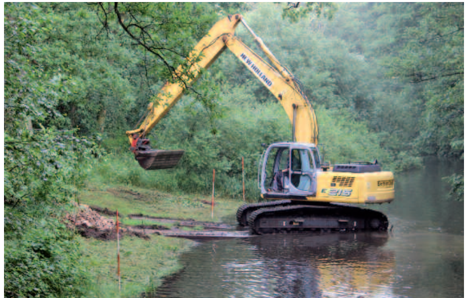
Nördlich des Hohenbuchenparks in Poppenbüttel baut ein Baggerfahrer eine Rausche aus Kies und Geröll – hoffentlich ein zukünftiger Laichplatz für Forellen [Projekt Lebendige Alster]
