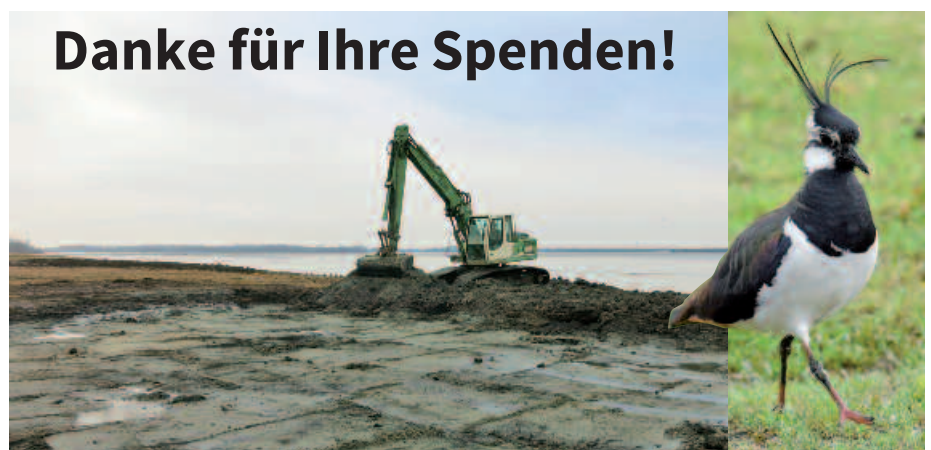
Spenden machten es möglich: Durch Baggereinsätze konnte neuer Lebensraum für den Kiebitz und andere Wiesenvögel geschaffen werden [M. Sommerfeld]
