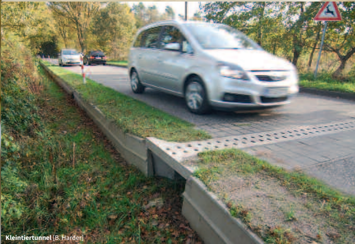
Kleintiertunnel [B. Harder]
