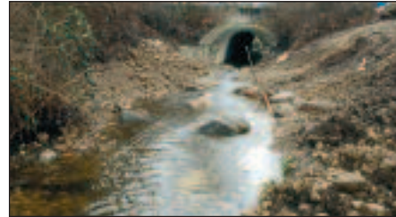
Die Seebek in Bramfeld vor (oben) und nach den Renaturierungsmaßnahmen
