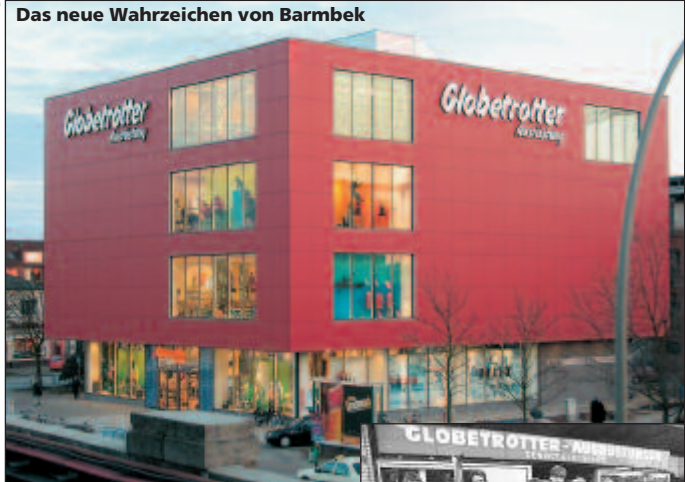
Das neue Wahrzeichen von Barmbek
