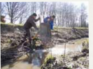
Kies einbringen am Jenfelder Bach
